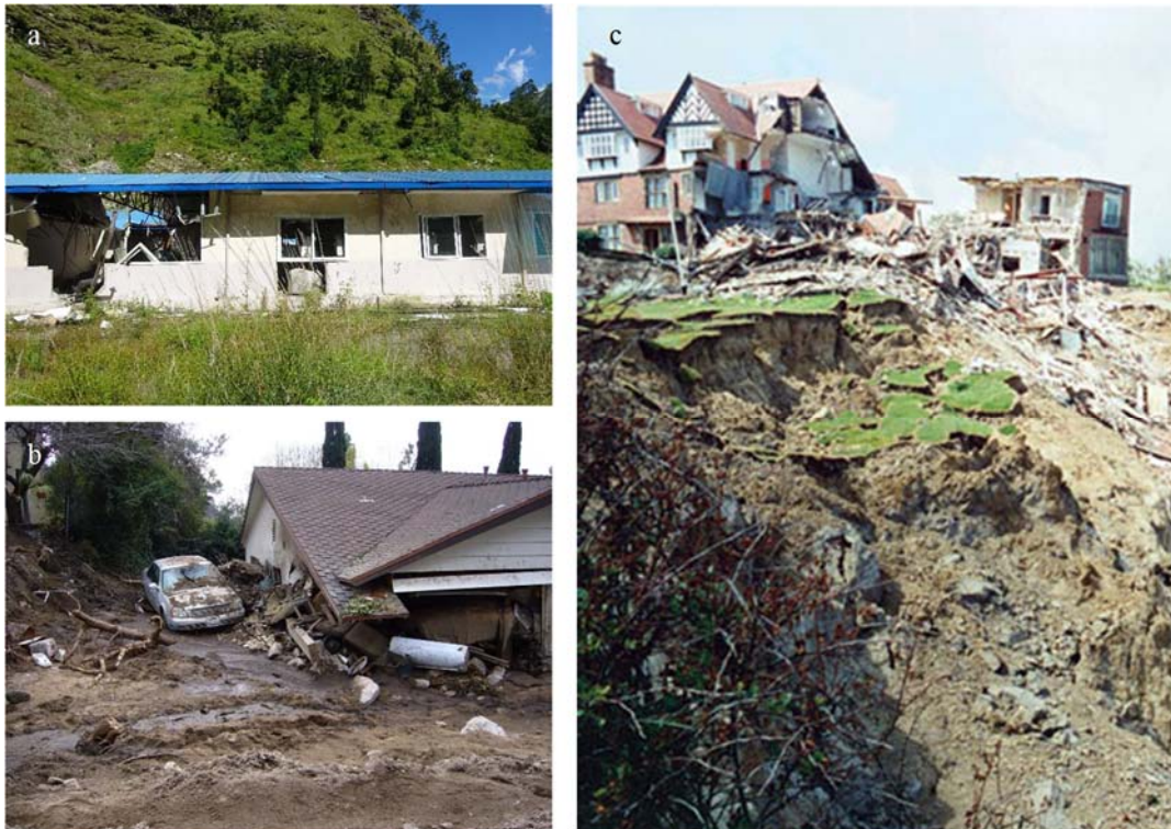
Figura 1 Edificios dañados por (a) desprendimientos rocosos en Nepal 2015, (b) corrientes de derrubios en California EU 2010 (fuente USGS), y (c) deslizamiento rotacional en el Reino Unido 1993 (fuente BGS)
